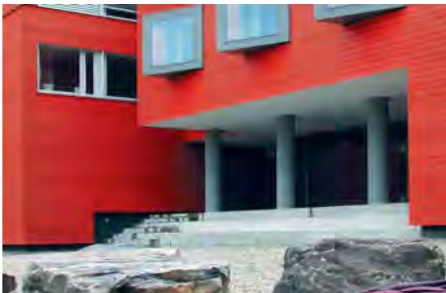
Detail des Studentenwohnhauses in Immensee: Die hinterlüftete, mit sägeroher Fichte geschalte Holzfassade wurde farblos tiefenimprägniert und mit einer Dreifach-Holzlasur pigmentiert. Der Bau wurde 2002 mit dem «prix pentol» ausgezeichnet. (Bild: Pentol/Lignum)
