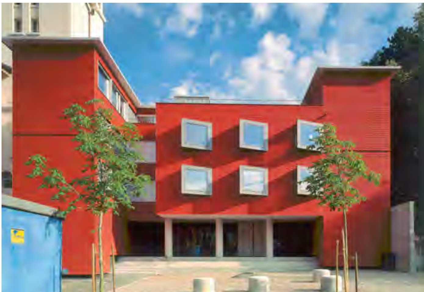
Das von den Architekten Herbert und Roman Oberholzer 1997 entworfene Internat in Immensee springt mit seiner rötlich lasierten Holzoberfläche ins Auge. (Bild: Hans Enge, Luzern/Lignum)
